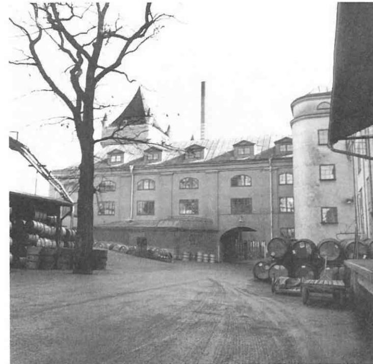
Västra portalen med vägen mellan tornhuset och lagerbyggnaden. Foto Cramér 1967. SSM
