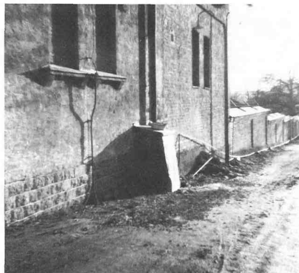
V&S:s stallbyggnad med vattenkran. Reimersholmes enda tappställe för dricksvatten
